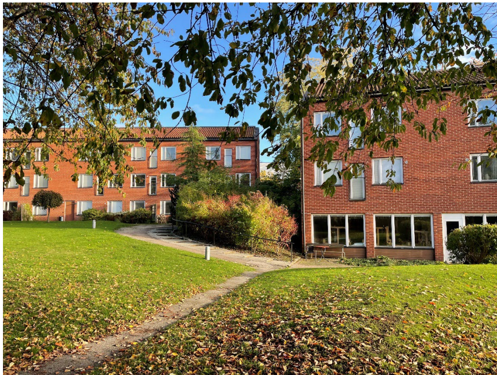
Befintliga lamellhus i suterräng, vy mot sydöst.
