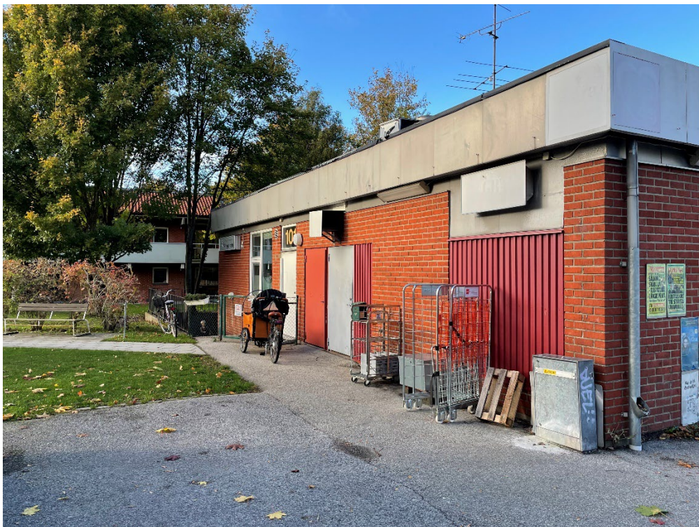
Fastigheten Riksvapnet 2 med trappa och entré till förskolan.
